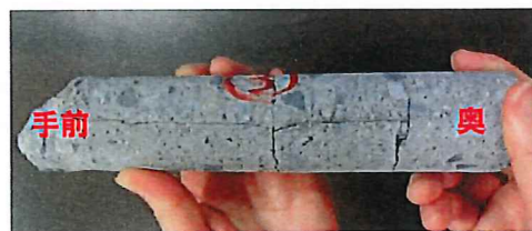
Photo 1 コア③. 3本に折れ、手前の2本は剥離したが、奥の1本は剥離しなかった。
