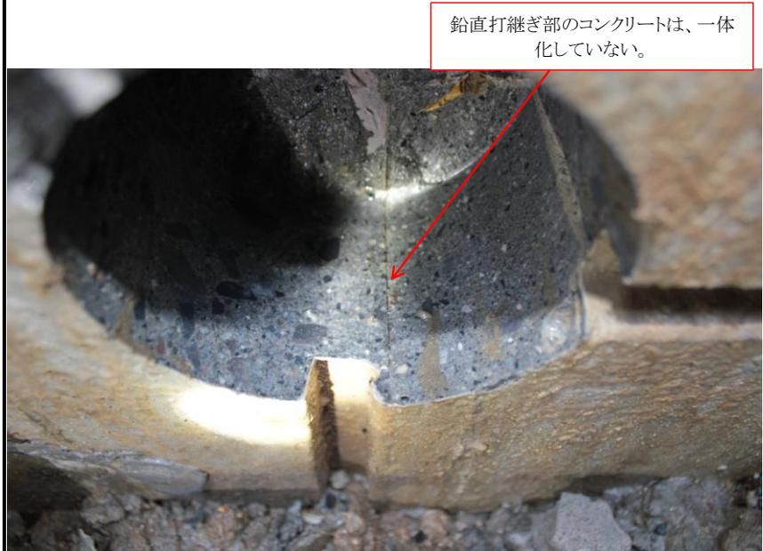
鉛直打継ぎ部のコンクリートは、一体化していない。
